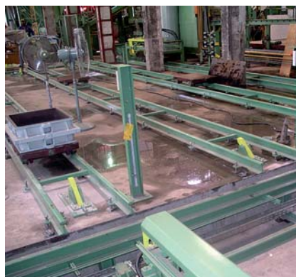
Immer wieder: Nach jedem Regen schoss das Wasser in die Produktionshallen. Die Ventilatoren sollten die Menschen vor der Schwüle schützen.
